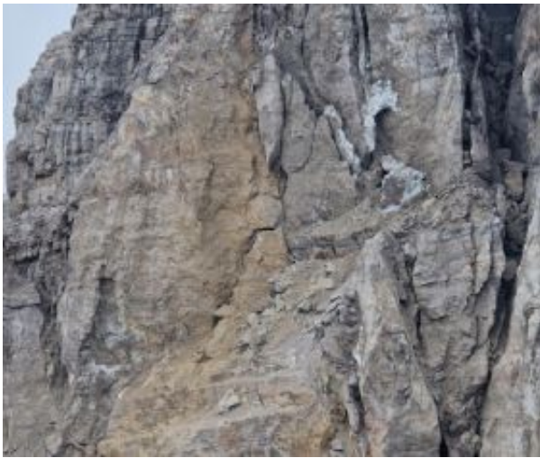
Fratture Le profonde crepe osservate e fotografate su Cima Falkner nel corso del sopralluogo in elicottero di lunedì da parte del servizio geologico della Provincia
