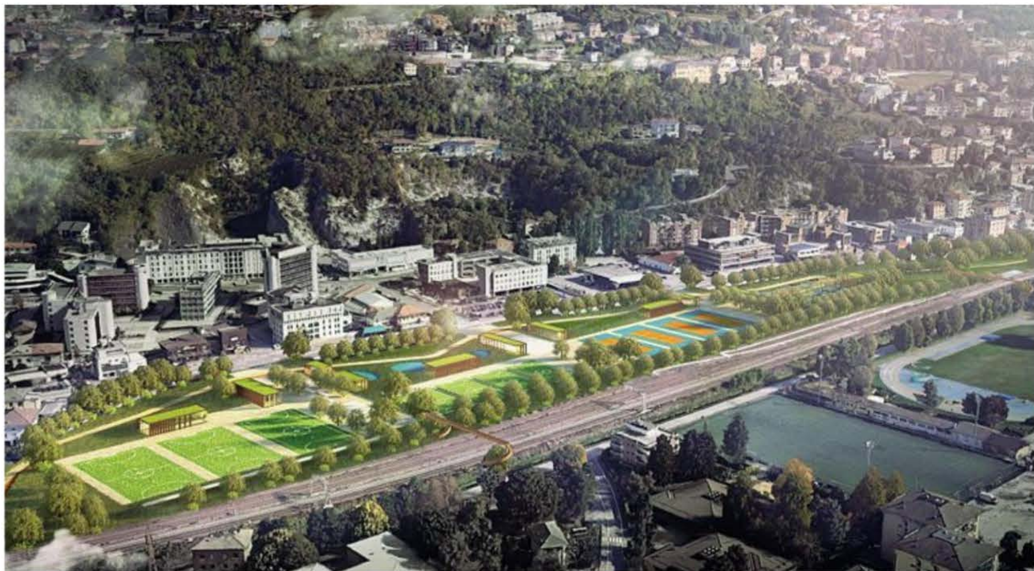
Via Brennero La trasformazione della zona a nord di Trento nell'ambito della realizzazione della circonvallazione ferroviaria
