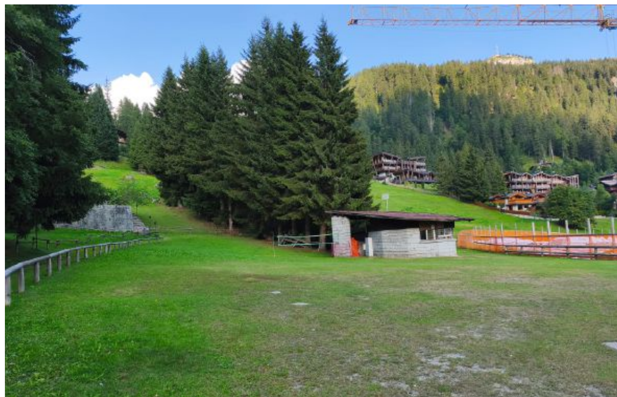
Belvedere L'area interessata al progetto con il rudere del vecchio skilift
