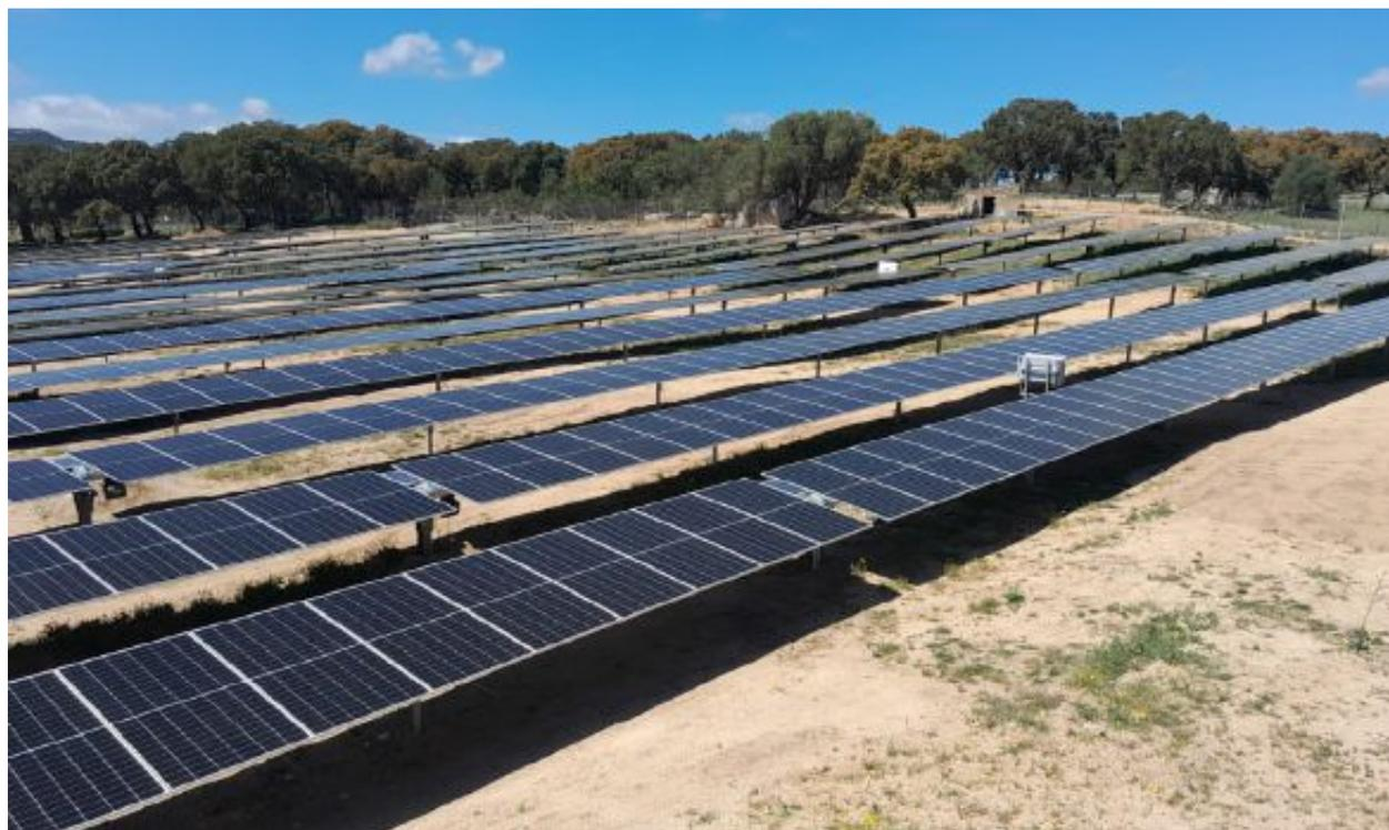
**Pannelli fotovoltaico** Il parco di Zuclo potrà produrre fino a 1000 kw
