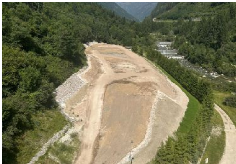
Canal San Bovo La discarica dove sono consegnati gli inerti dello Scalo Filzi
