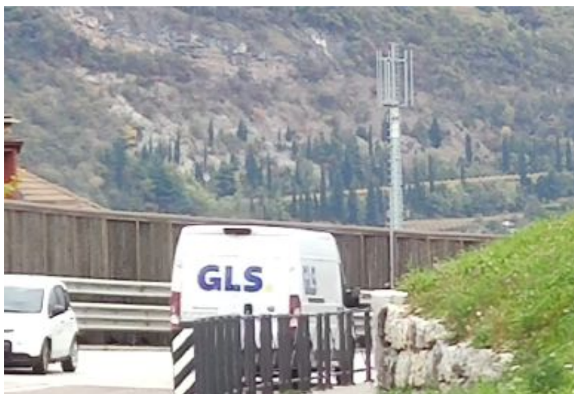
Telecomunicazioni La nuova infrastruttura a Sant'Ilario è alta 24 metri
