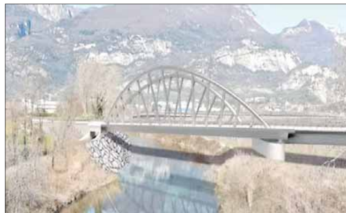
Il ponte in «diagonale» che scavalcherà il Sarca circa a metà del percorso
