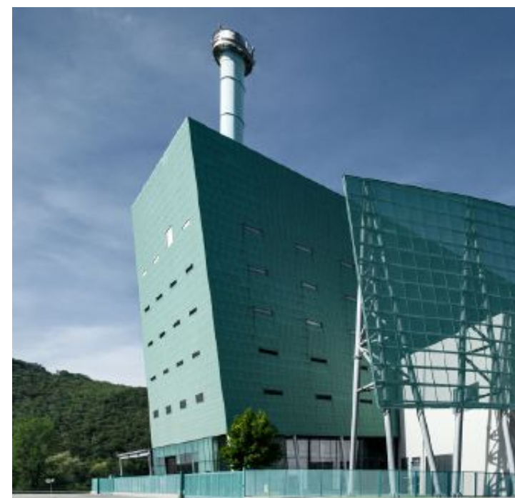
Impianto Termovalorizzatore di Bolzano
