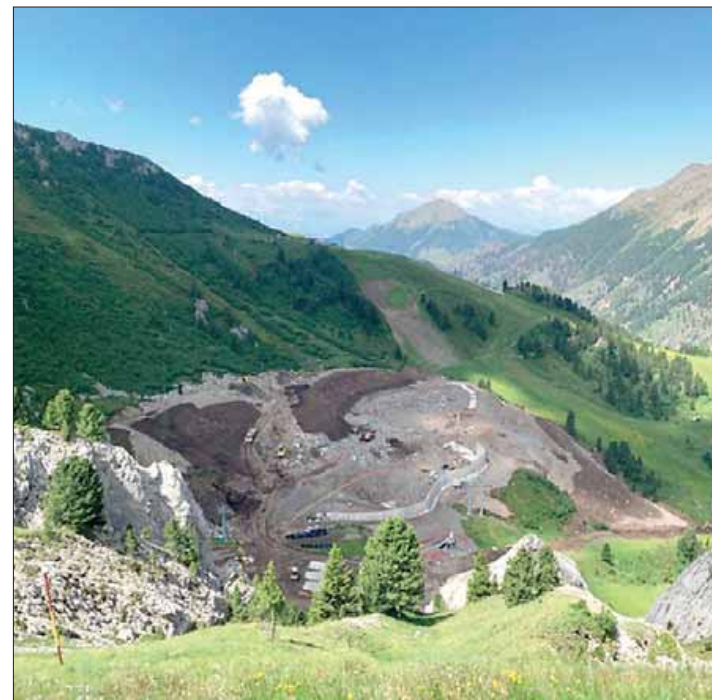
Un'immagine dello scavo per il bacino artificiale di Pampeago
