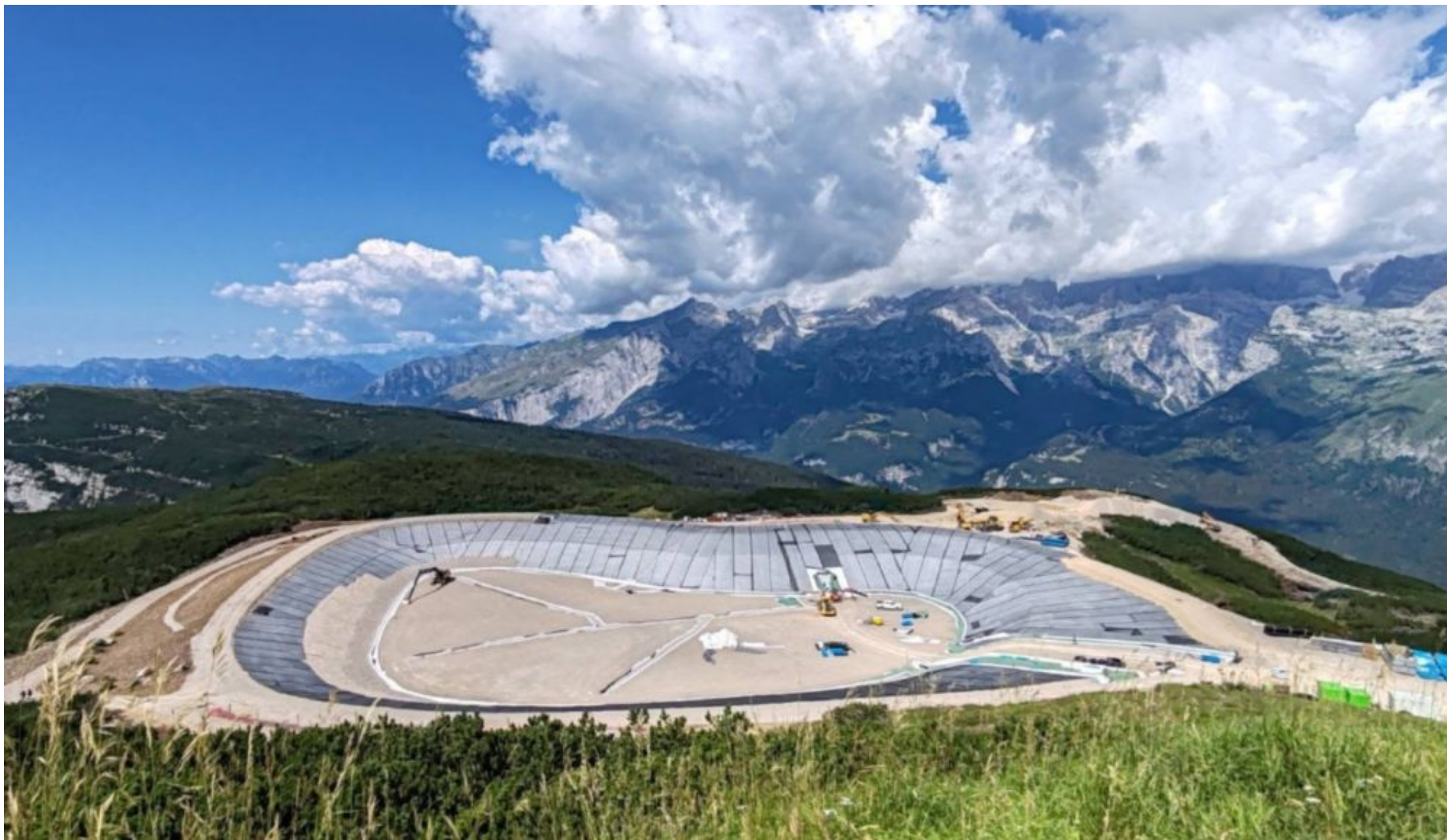
Lavori La costruzione del bacino artificiale nella Paganella
