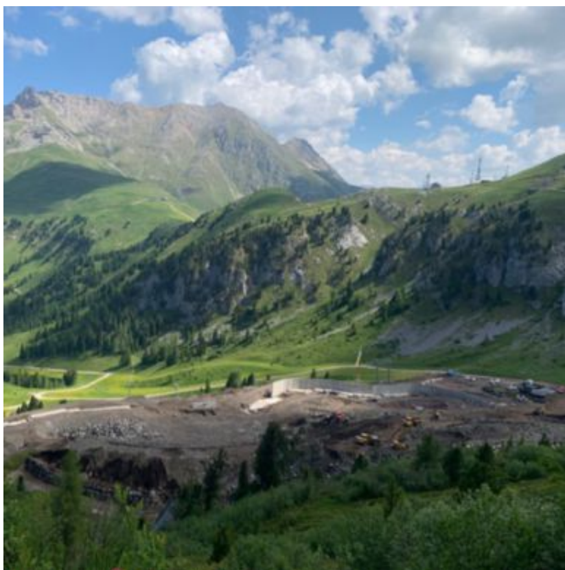
L'intervento Il bacino artificiale di Pampeago
