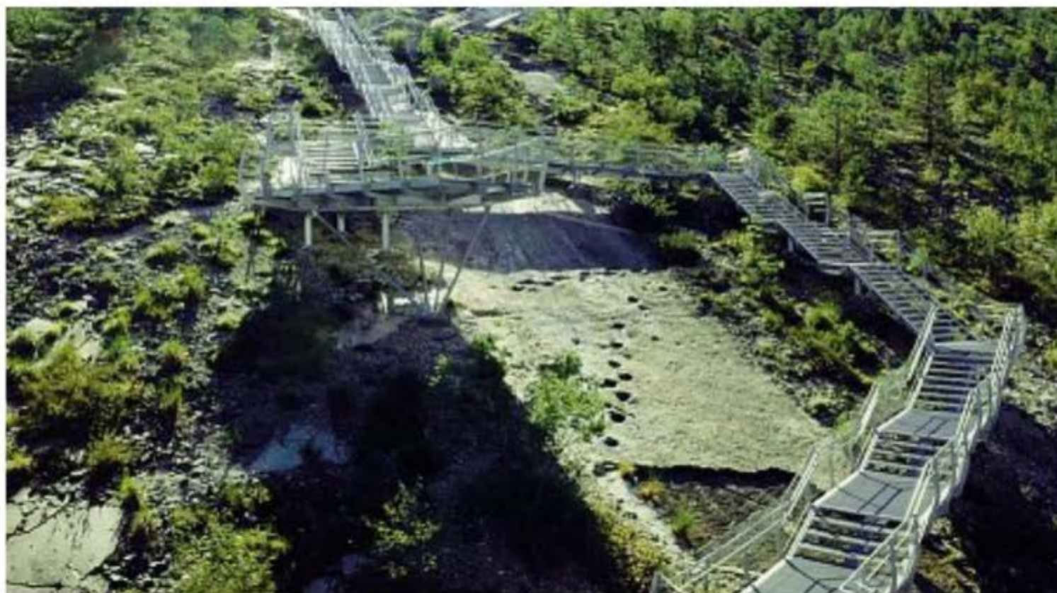
Nel mirino Le passerelle metalliche sospese realizzate ai Lavini di Marco
